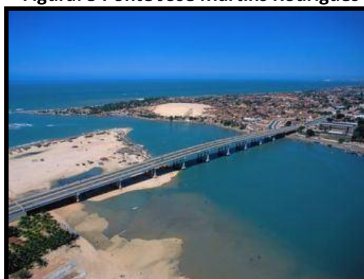
Figura: 5 Ponte José Martins Rodrigues
