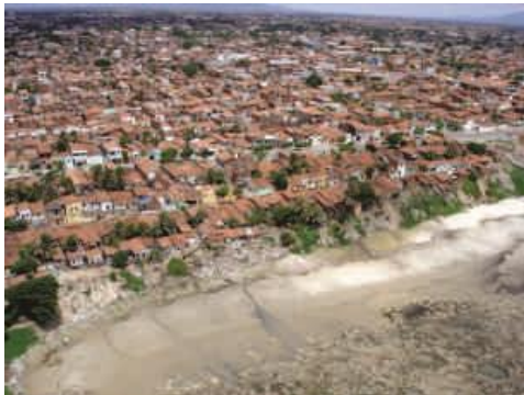
Figura 05: Vista Aérea - Orla Degradada
