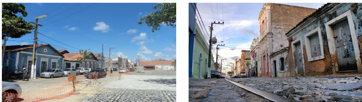
Imagem 06. Rua Chile, Bairro da Ribeira, Natal/RN (Casario em frente as obras e entorno do Porto)
