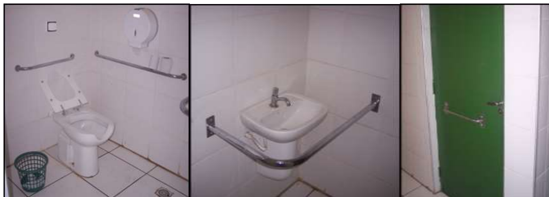
FIGURA 3. Boxe para deficientes no sanitário público da Praça Rui Barbosa.
