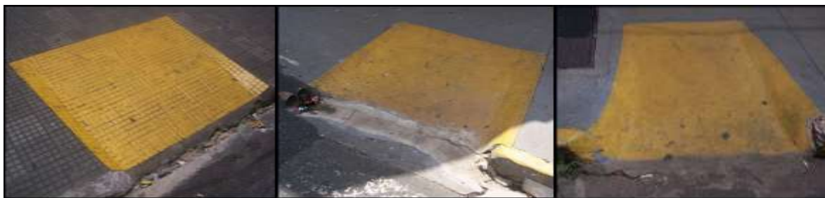
FIGURA 2. Rebaixamento de calçadas na área de estudo: (a) Início da quadra 7; (b) Final da quadra 7; (c) Final da quadra 7 (Rua Bom Jesus).
