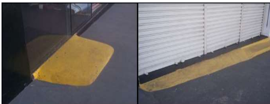
FIGURA 5. Rampas de acesso ao interior das lojas: (a) Loja 1 – rampa estreita; (b) Loja 2 – rampa larga.
