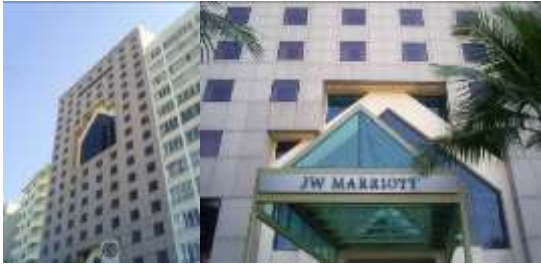
Figura 13. Sequência de imagens do JW Marriot Hotel, Rio de Janeiro, RJ. Da esquerda para a direita: fachada junto ao passeio da Avenida Atlântica, detalhe da fachada com pórtico de entrada.
