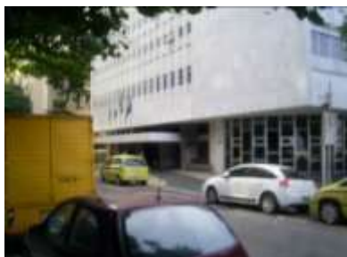
Figura 03. Fachada da esquina do Hotel Leme Othon Palace, Rio de Janeiro, RJ.
