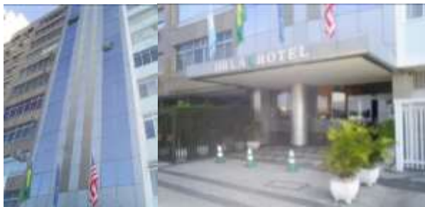
Figura 16. Sequência de imagens do Rio Orla Copacabana Hotel, Rio de Janeiro, RJ. Da esquerda para a direita: fachada principal e detalhe de cobertura da entrada.
