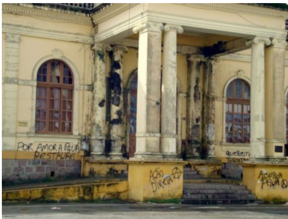
Figura 1- Estação Ferroviária de Paranaguá Agosto, 2014.
