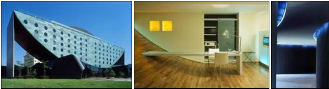
Fachada, UH e corredor dos andares do Hotel Unique . Fotos de Nelson Kon, disponíveis em http://www.vitruvius.com.br/institucional/inst109/inst109.asp , consulta em 24/03/2007.
