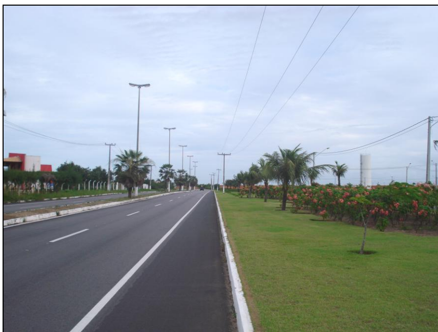
Figura 01 – Rota do Sol em Parnamirim/RN: acesso ao Alphaville Natal. Fonte: Saulo Gomes, 2008.
